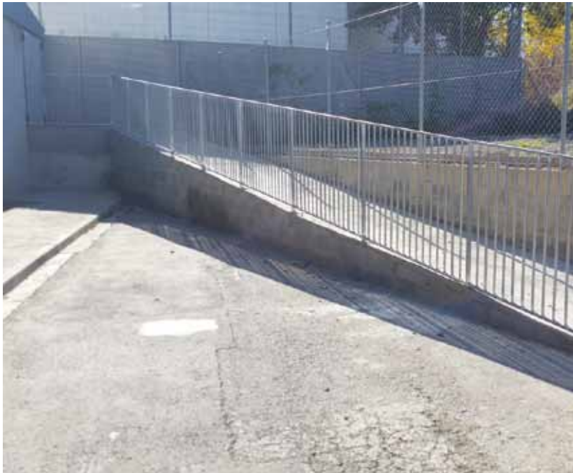
La nova rampa d'accés a les grades del pavelló
