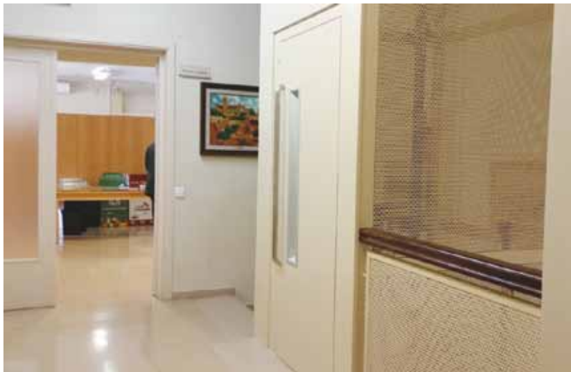
El nou ascensor de l'edifici de l'Ajuntament
